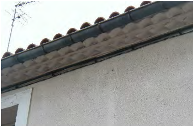
42 rue des Aiguerelles Débord de toit sur génoise deux rangs avec gouttière pendante en zinc.
