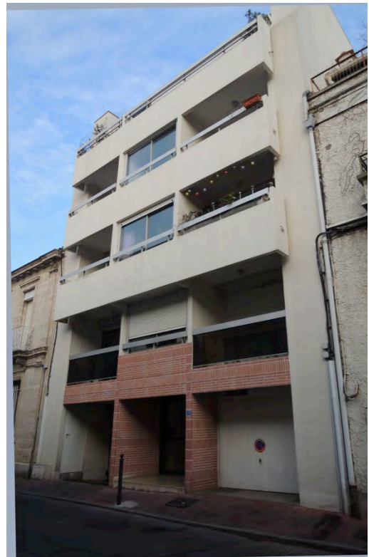
rue Cité benoît (architecte M.Bernard)
