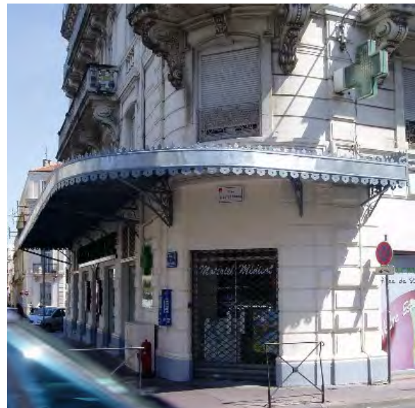
2 rue Frédéric Bazille Marquise métallique
