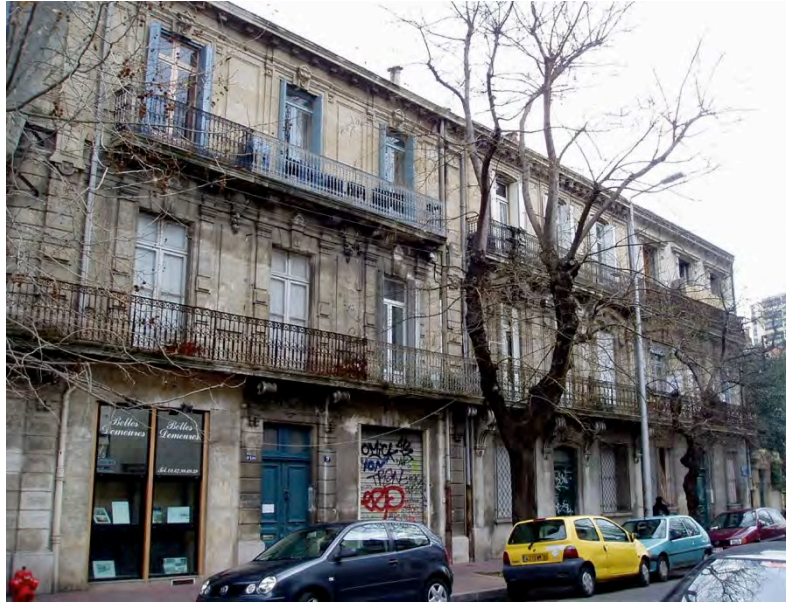
9, 11, 13 avenue du Pont Juvénal
