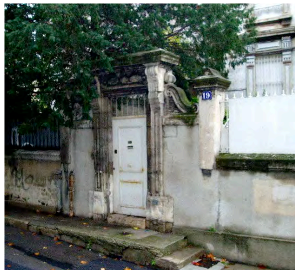
19 avenue du Pont Juvénal
