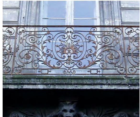
17 rue des Deux Ponts
