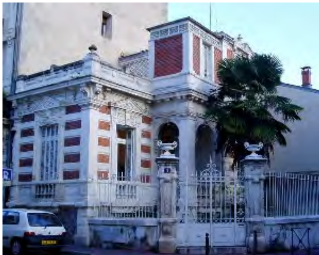
5 rue des Aiguerelles décor en briques et en pierre
