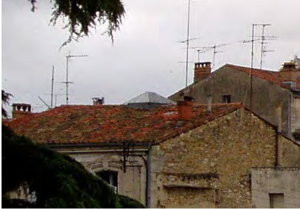
4 avenue du Pont Juvénal
