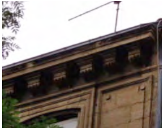
11 et 13 avenue du Pont Juvénal Corniche à modillons en pierre de taille Les corniches supportent des chéneaux en zinc
