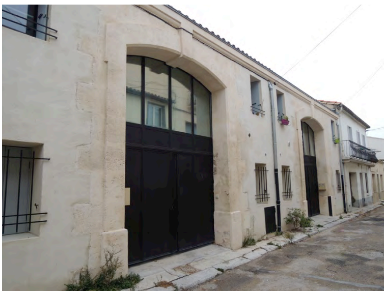
Restructuration de remises
