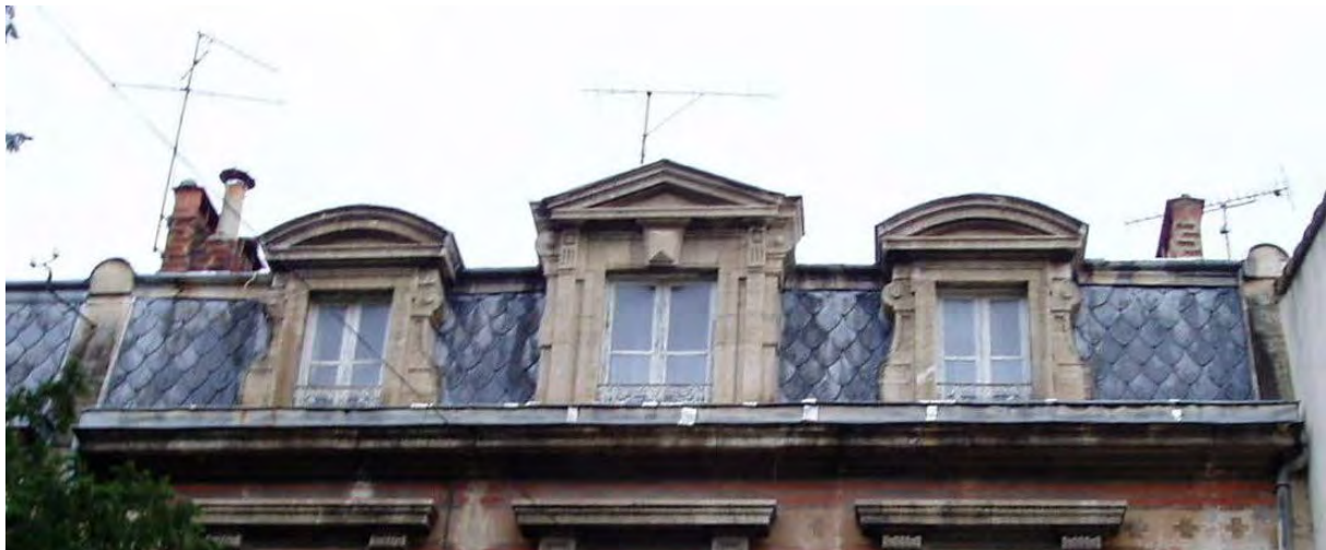
19 avenue du Pont Juvénal
