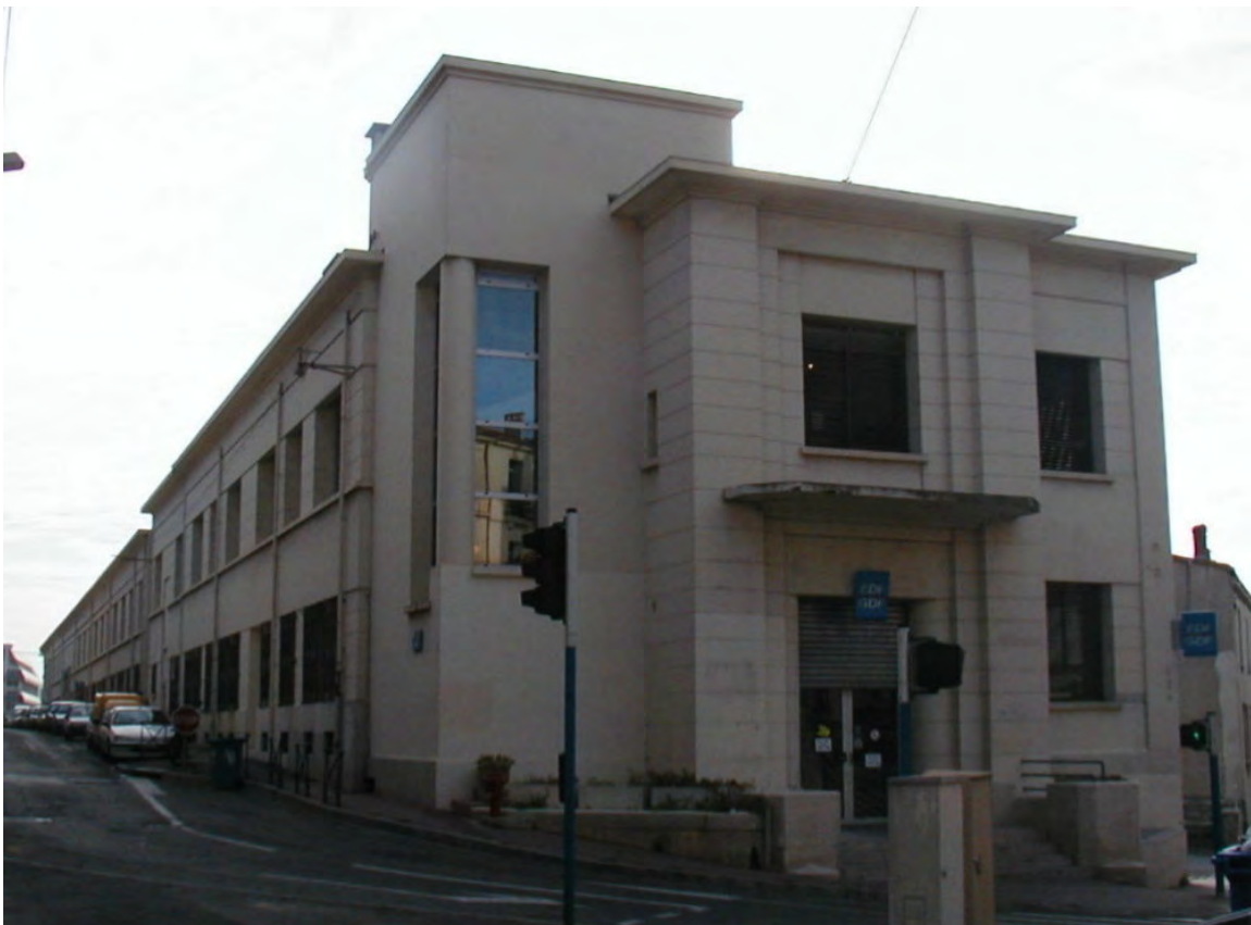
Ancienne usine EDF, 17 rue du Pont de Lattes
