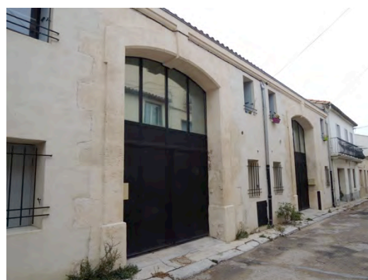
Hangar réhabilité rue de Constantine
