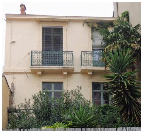
Le remplacement de la fenêtre par un modèle strictement identique à celui d'origine est quasiment imperceptible
