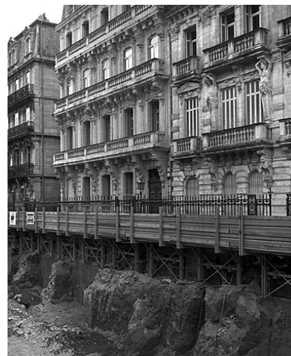
Construction des immeubles sur le rempart (base Mérimée, ministère culture)
