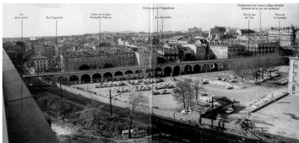
1973 le viaduc du chemin de fer de Palavas vu depuis la nouvelle mairie.
