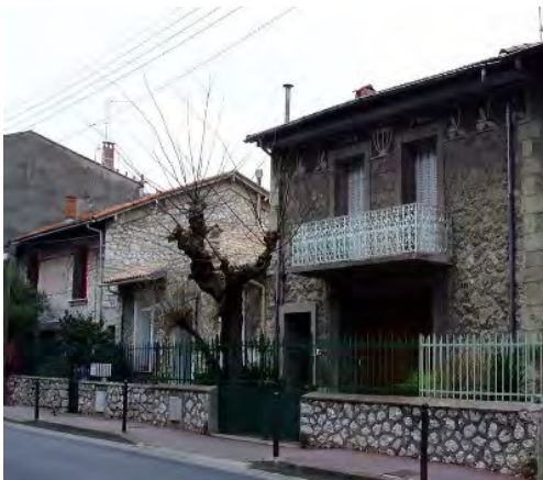
14,16 avenue de Palavas, maisons avec décor en frise. Façades en moellons de pierre début XX e siècle
